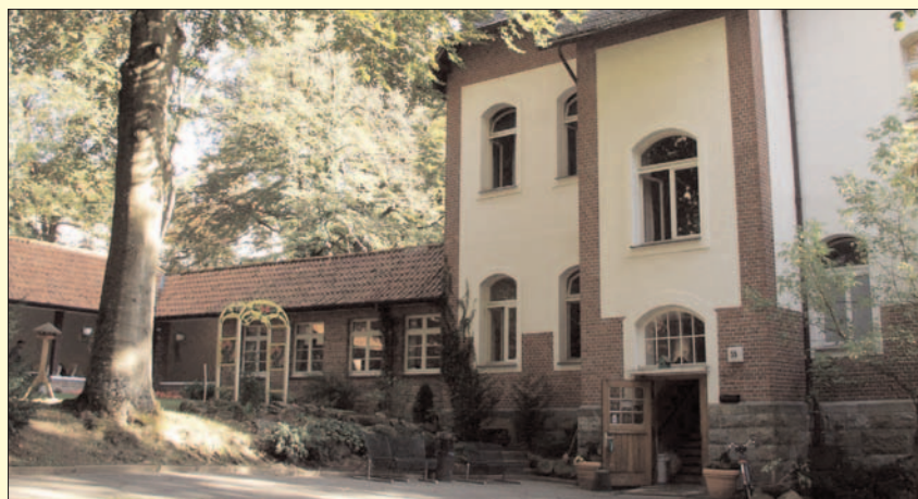
Haus Domagk mit Verbindungsgang zum Haus Brehmer.
