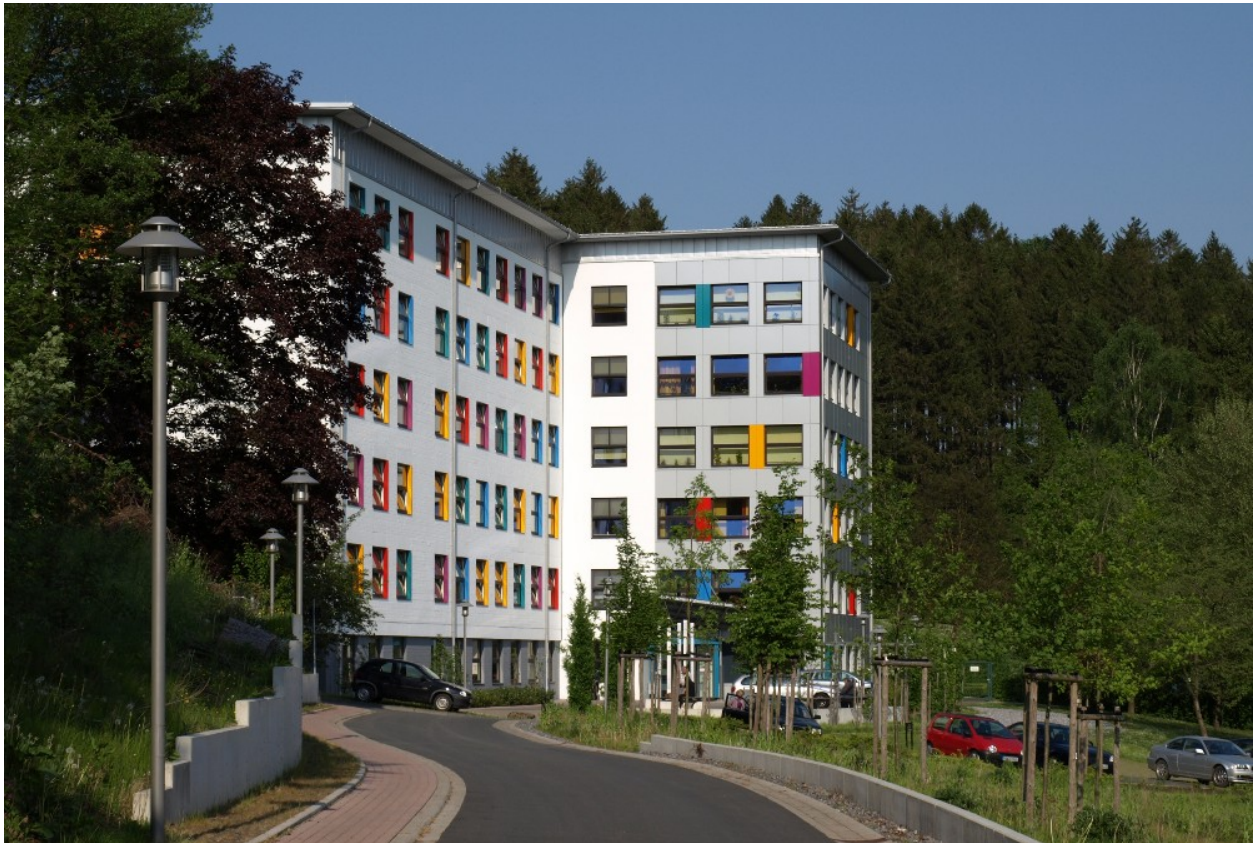
Stationsgebäude LWL-Klinik Warstein
