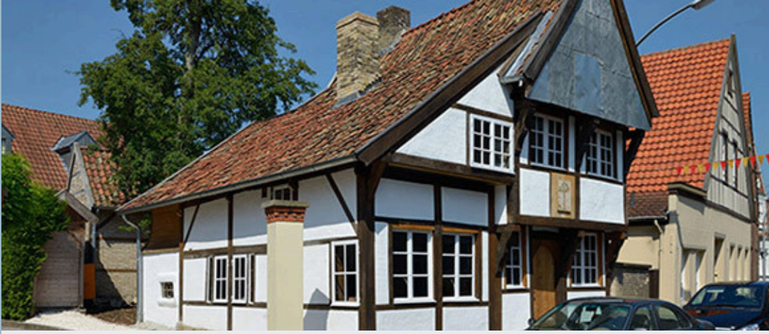
Das Fachwerkhaus Berenbom in Steinfurt erhielt den Preis im Jahr 2013. Foto: LWL/Dülberg.
