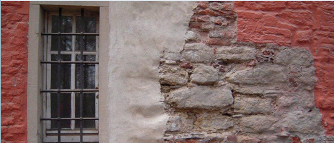
Haus Lüttinghof in Gelsenkirchen. Freigelegte Musterfläche in ungereinigter Strahltechnik zur Planung der Sanierungsmaßnahmen an den Fassaden. Foto: LWL/Ochsmann
