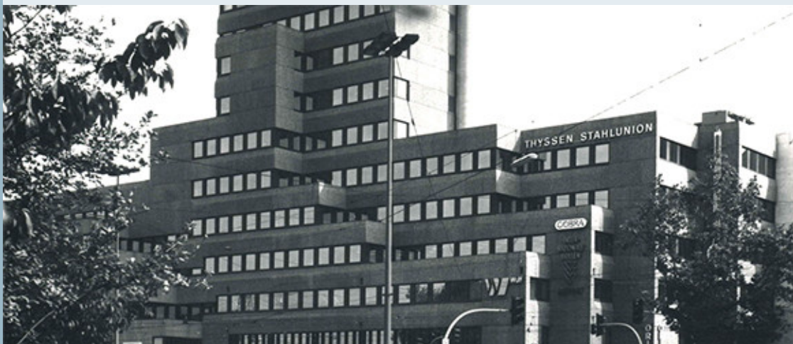
Ehemaliges Volkswahlbund-Gebäude in Dortmund. Foto: A:AI Archiv für Architektur und Ingenieurbaukunst NRW, TU Dortmund, Nachlass Harald Deilmann.
