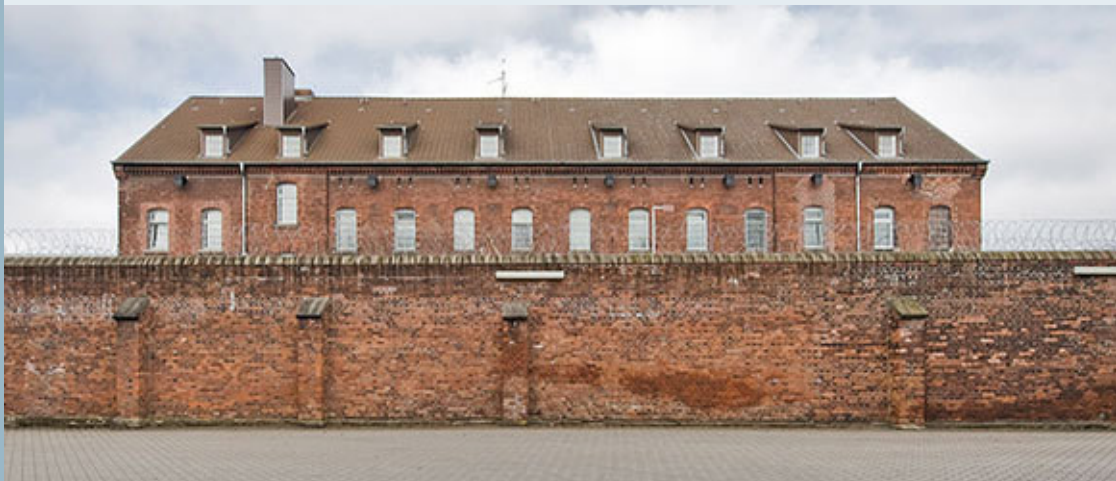
Die JVA Münster, Ansicht der Gefängnismauer, dahinter das historische Arbeitshaus. Foto: LWL/Dülberg.
