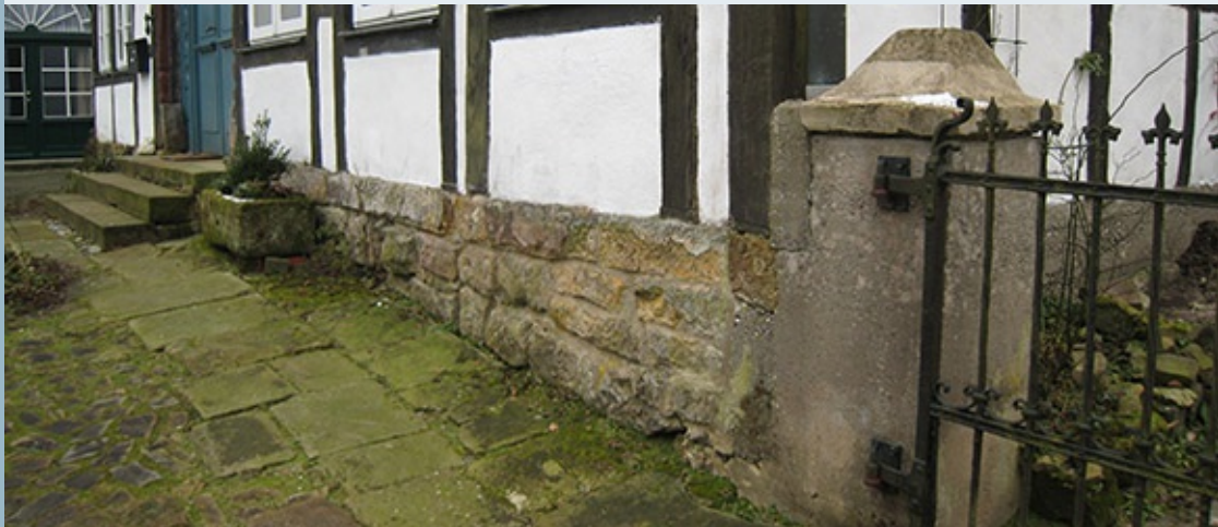
Holzbohlen als horizontale Sperre unter dem Fachwerkständer eines Hauses in Steinfurt. Foto: LWL/Seifen.
