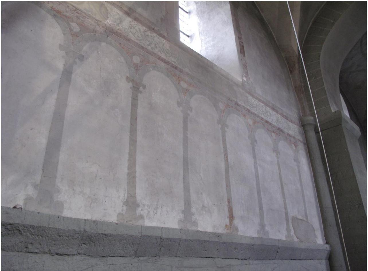
Das gemalte Triforium fußt auf dem plastischen Gesims, das hier in Form einer Schräge (oder Schmiege) mit Deckplatte ausgebildet ist.
