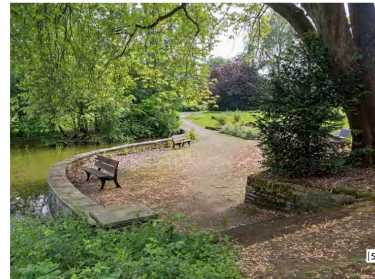
Der Teich zeigt eine geschwungene Uferlinie, die am Südufer von regelmäßigem Natursteinschichtmauerwerk gebildet wird. Die begrenzende, ca. 40 Zentimeter hohe Mauer ist mit breiten Abdeckplatten aus Sandstein belegt.
