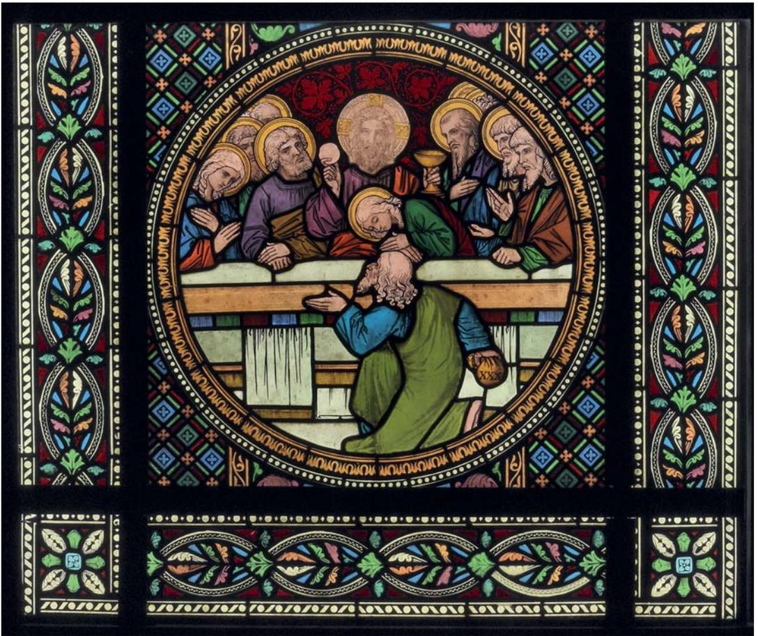
7 Scheitelfenster der Chorapsis, untere Scheibenfelder mit Darstellung des Abendmahls im Durchlicht von innen, nach der Restaurierung: partiell reduzierte Schwarzlotbemalung in Gesichtern und Gewändern. Foto 2020.
