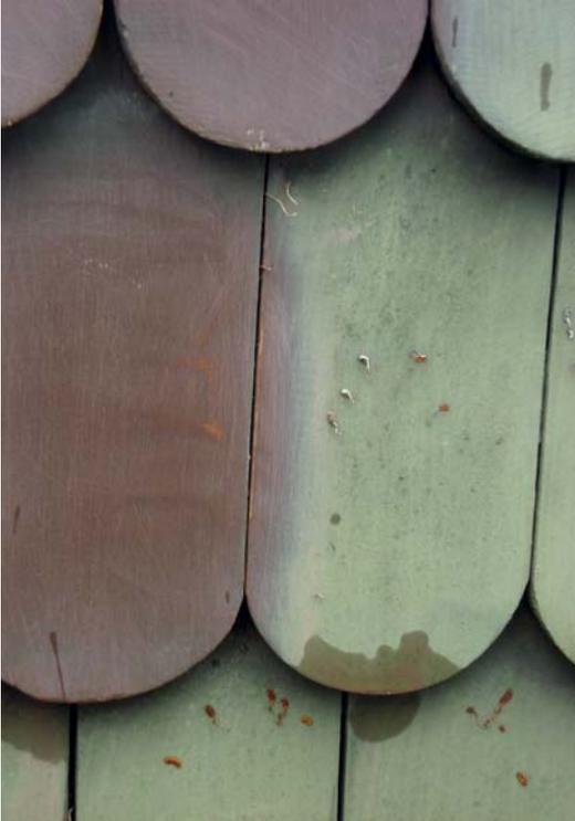
9 Detmold, mit Holzschindeln verkleidete Fassade; relativ dünner Schichtaufbau mit einer Talkum enthaltenden Leinölfarbe; nach zehn Jahren hat sich das Bindemittel abgebaut und die Schichtdicke reduziert; das Talkum hat sich an der Oberfläche abgelagert und diese grün verfärbt. Foto 2015.
