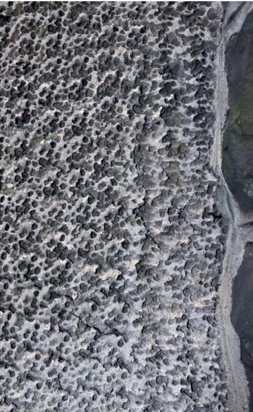
4 Plettenberg, Wohnhaus Lehmkuhler Platz (1908), Edelputz-Oberfläche: Rutenbündelstippputz mit vergleichsweise tiefen, dicht beieinanderliegenden „Löchern“. Für die Herstellung der Struktur kam ein vergleichsweise kleines Rutenbündel zum Einsatz. Die einzelnen Stippen lassen sich gut differenzieren, sie wurden nebeneinander angeordnet und folgen zumeist leicht geschwungenen Reihen.
