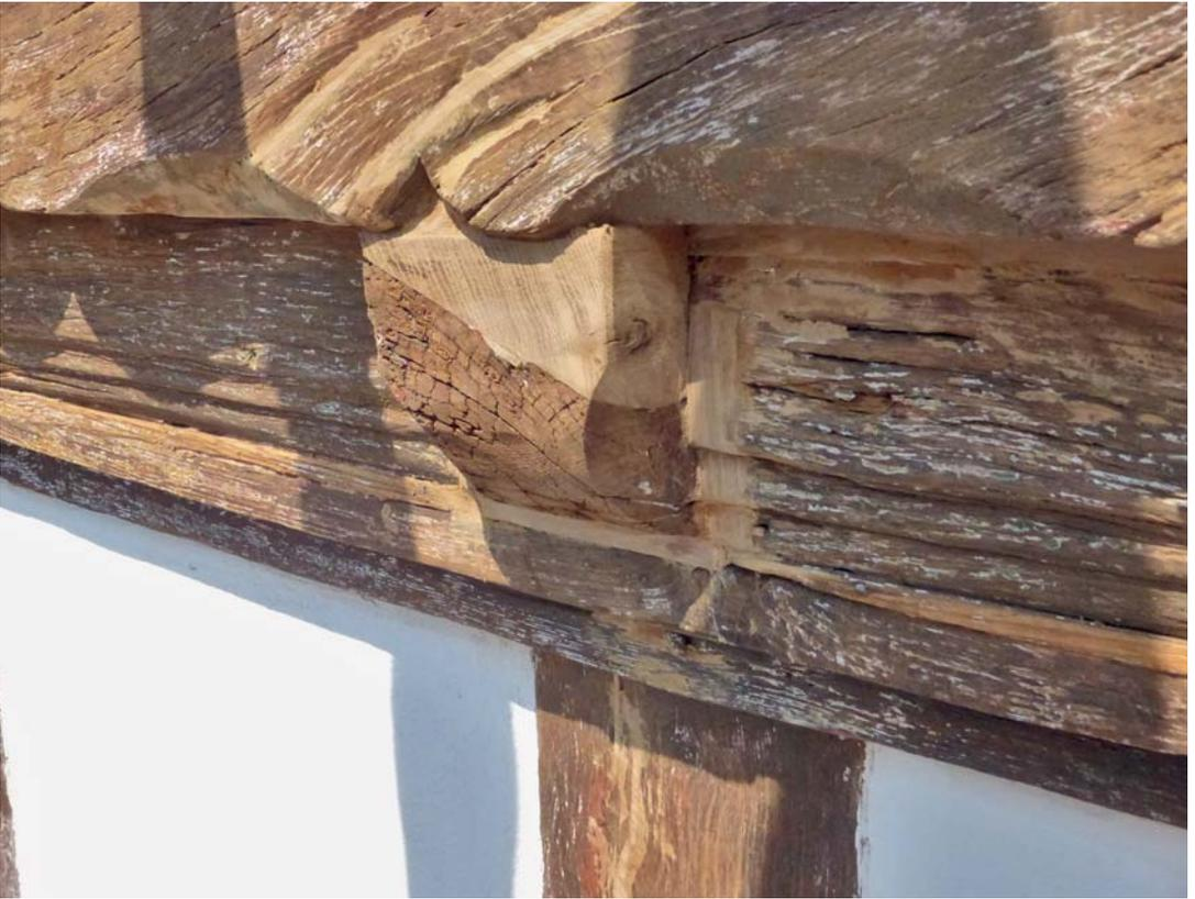
6 Schieder-Schwalenberg, verzierte Fachwerkfassade; die Farbfassung wurde abgenommen, das geschädigte Holz gefestigt, zu stark geschädigte Substanz wurde entfernt und durch Einleimung von Holz erneuert, kleine Fehlstellen wurden gekittet. Foto 2018.
