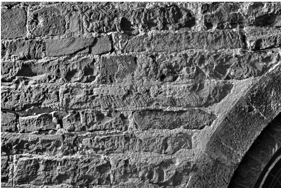
2 Lippstadt, ev. Große Marienkirche, Südquerhausostwand, Mauerwerksoberfläche aus grob geglättetem Bruchstein mit verstrichenem Mauermörtel und Fugenritzung (Pietra rasa), 1. Hälfte 13. Jh. Zustand nach der Vorbereitung der Oberfläche für den Auftrag eines neuen Verputzes. Foto 1994.
