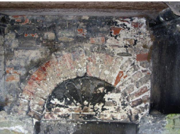
Welver, Haus Nehlen. Durch einen Erker geschützte Fassungsbefunde im Bereich der Fassade. 2011.
