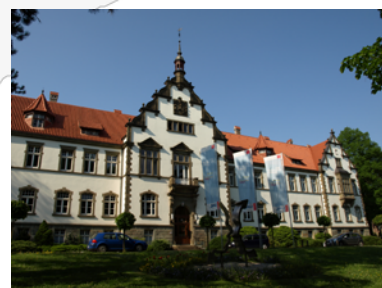
LWL-Klinik Warstein, einschl. Tagesklinik, Institutsambulanz, Rehabilitationszentrum und Institut für Rehabilitation
