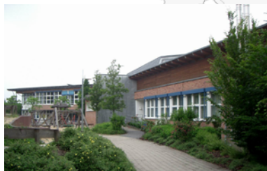
Hedwig-Dransfeld-Schule, LWL-Förderschule, Förderschwerpunkt körperliche und motorische Entwicklung
