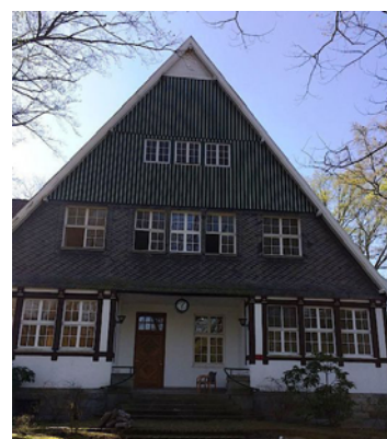
LWL-Tagesklinik und LWL-Institut- sambulanz Gütersloh, Außenstellen der LWL-Universitätsklinik Hamm
