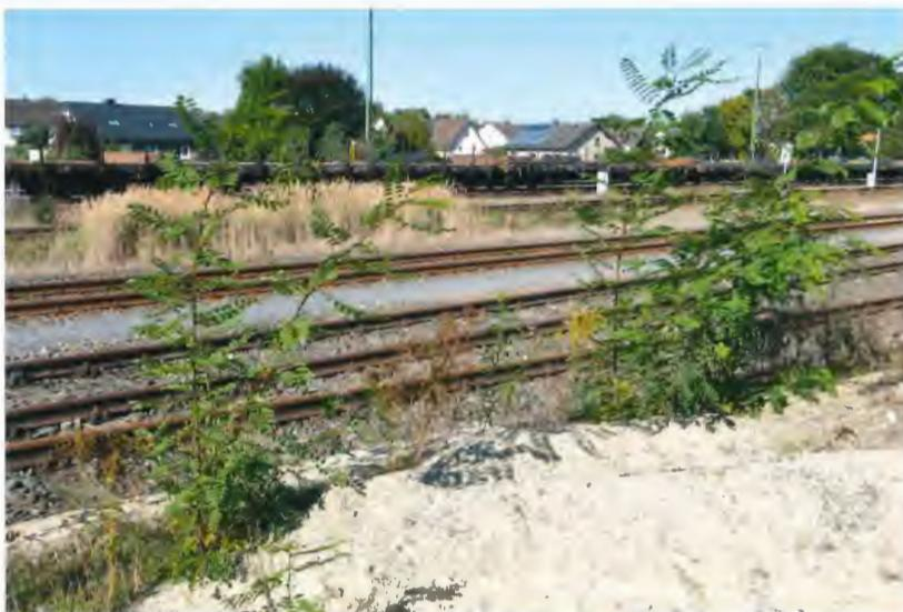
Foto 7: Robinienaufwuchs an Gleisrändern beim Bhf. Sennelager.
