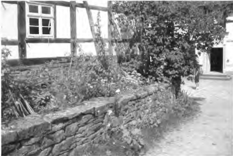
Abb. 1: Trockenmauer im Freilichtmuseum Detmold (Foto: P. Schäfer)
