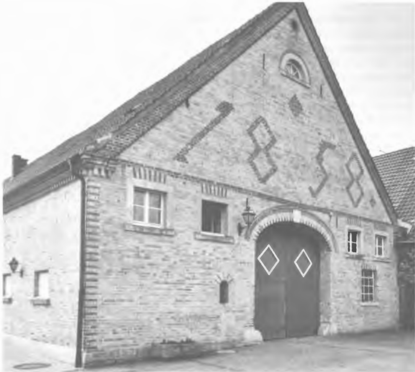
Foto 1: Typisches Hauptgebäude eines münsterländischen Bauernhofes mit Ziegel- und Sandsteinband unterhalb der Dachrinne, als Brutplatz von Mehlschwalben nicht geeignet.
