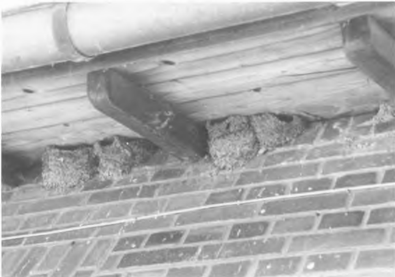
Foto 4: Unverkleideter Dachsparren mit Mehlschwalbennestern
