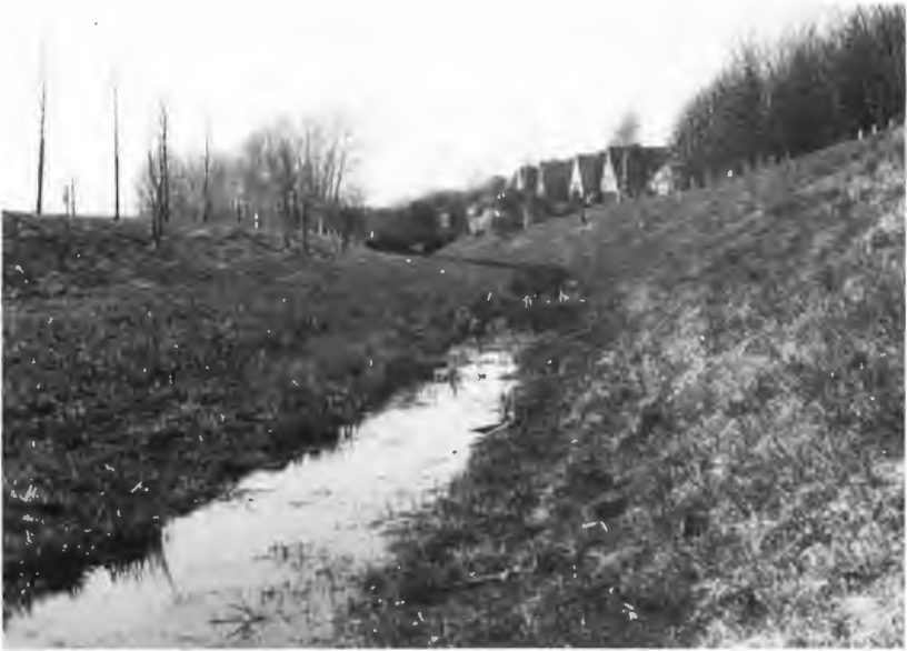
Abb. 1: Regenrückhaltebecken „Rumelner Bach“ (Duisburg) im Februar 1979.
