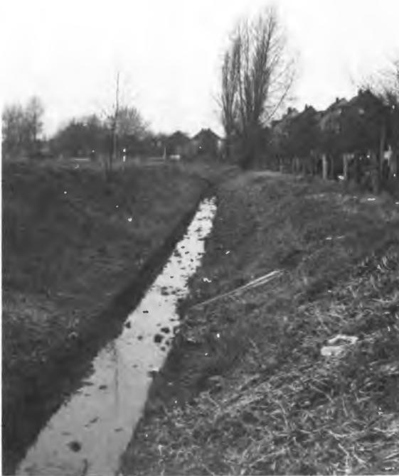
Abb. 3: Hinterer Grabenabschnitt nach dem Zulauf von Mischwasser (März 1982)
