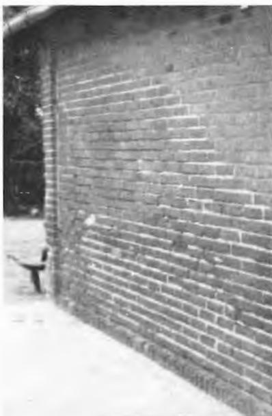
Abb. 1. Mauer eines Schuppens mit leergepickten Mörtelfugen.
