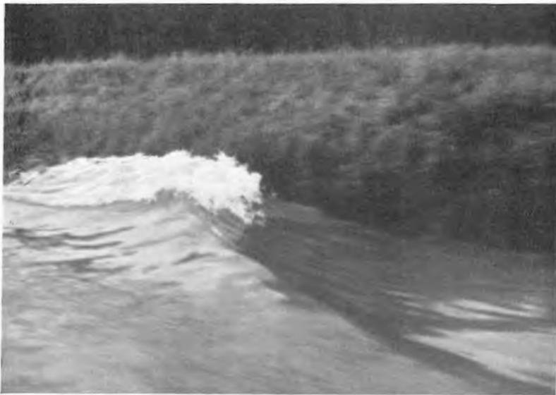
Abb. 2. Von einem Motorschiff erzeugte Brandungswelle an einer Kanalböschung. Ist das Ufer durch einen dichten Schilfgürtel geschützt, richtet die Welle keinen Schaden an.
