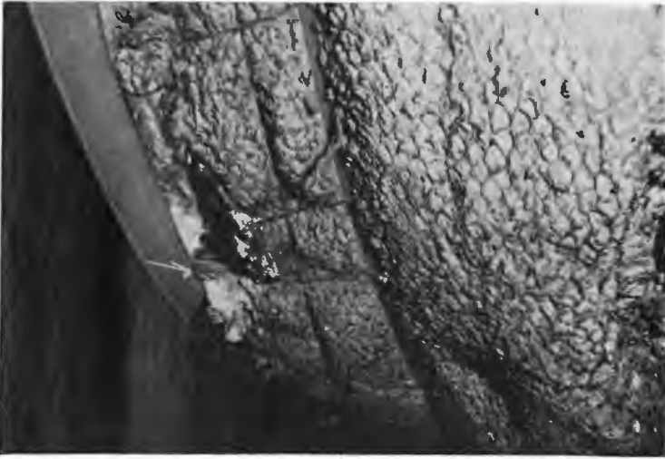
Abb. 7. Nest eines Zaunkönigs (Pfeil) in der Isolierumkleidung einer Benzoldestillierblase.
