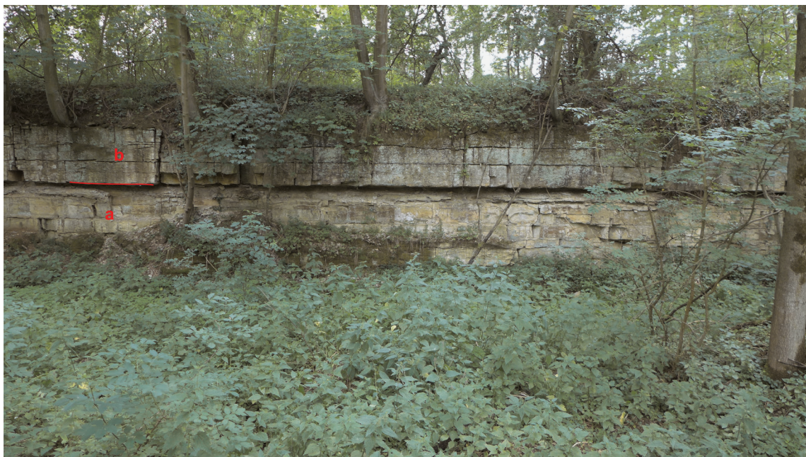
Abb. 23: Büren-Böddecken, aufgelassener Steinbruch östlich vom Gut an der L 751, TK 25 Blatt 4418 Wünnenberg, Rechts 3478145, Hoch 5717900, NN + 255 m, a Oerlinghausen-Formation, b Salder-Formation, Soest-Grünsand-Subformation, Oberturonium, Subprionocyclus neptuni -Zone (Aufschluss 14).
