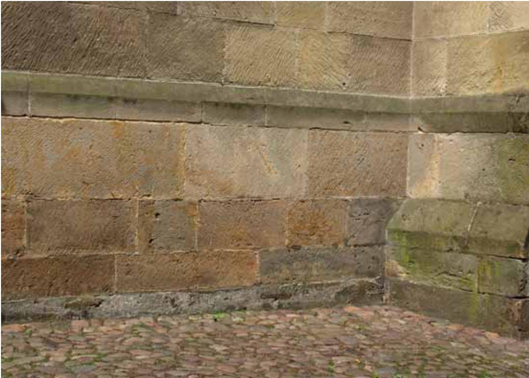
Abb. 16: Sockelmauerwerk an den Chorkapellen am Dom zu Münster (vermutlich Gravenhorster Sandstein)
