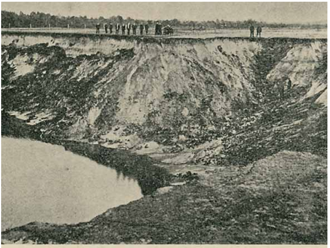
Abb. 21: Ein besonders eindrucksvolles Beispiel eines rezenten Erdfalles wird von TIETZE (1914) und WEGNER (1913) aus dem Subrosionsgebiet des Heiligen Feldes beschrieben: Danach war am 14. April 1913 ein Erdfall von etwa 300 m Durchmesser und 10 – 15 m Tiefe plötzlich eingebrochen (Foto aus: THIERMANN 1975a).
