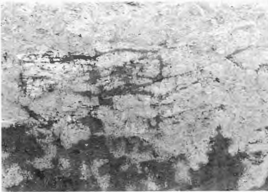
Abb. 6: Südlicher Teil der Westwand. Irreguläres Kluftsystem im mittleren Teil des Profils. Dunkle Partien im Bild: durchfeuchtete Tonmergel, hell: oberflächlich abgetrocknete Tonmergel.
