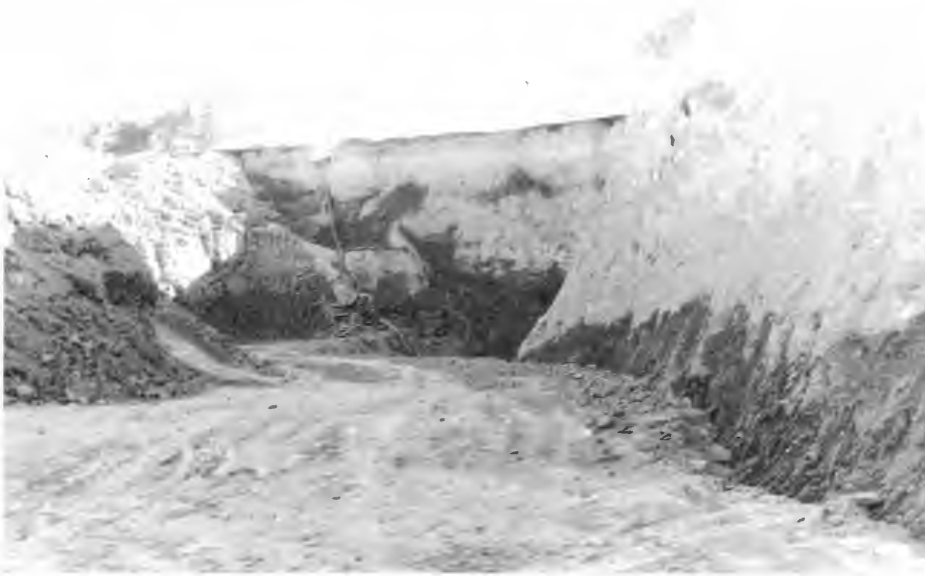
Abb. 4: Totalaufnahme des schmalen Aufschlußteiles zwischen Südteil der Westwand und Rampe der Einfahrt. Unterhalb der Südwand liegt die Pumpstation mit dem tiefsten (z. T. wassergefüllten) Aufschluß der Grube.
