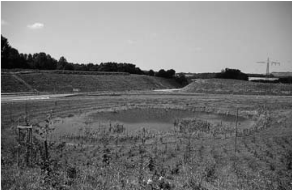
Abb. 13: Die Anlage von Kleingewässern in direkter Straßennähe (hier Neuanlage an der Autobahnausfahrt der A44 „Hückelhoven-Ost“) ist aus Artenschutzgründen zu vermeiden (Foto: A. Pardey)
