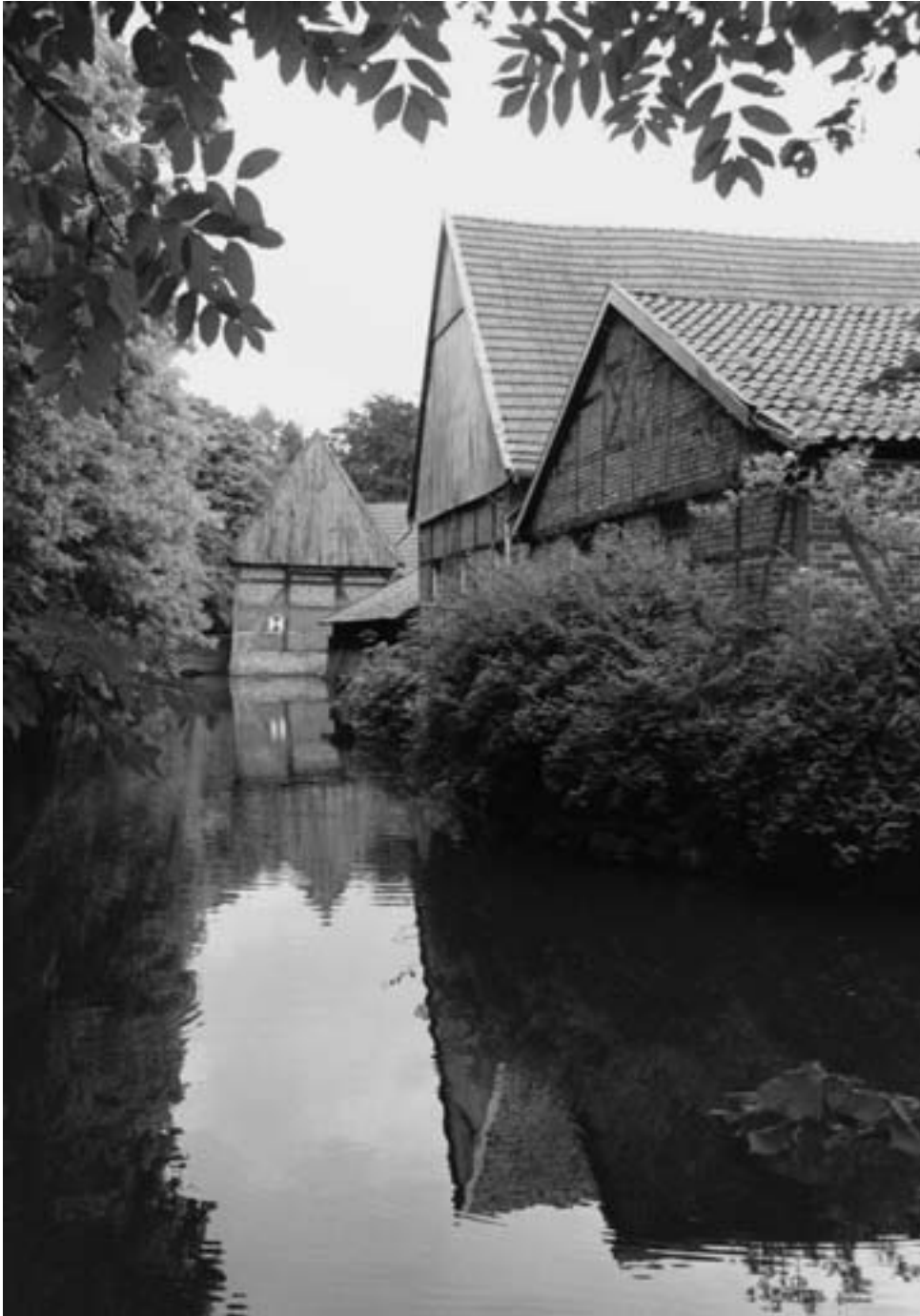
Foto 11: Die Außengräfte um das Haus Runde, die von einem Nebenbach der Steinfurter Aa gespeist wird, wurde über Jahrhunderte hinweg kaum verändert. Verschwunden ist dagegen die innere Gräfte, die früher den Speicher umgab, der in unruhigen Zeiten das wertvolle Korn schützen sollte. (Foto: B. Tenbergen, 2004)
