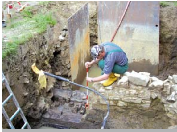
Abb. 23: Spenge. Die freigelegte Umfassungsmauer der Werbung aus dem 16. Jahrhundert wird sorgfältig vermessen. Um der Mauer in der sumpfigen Umgebung die nötige Standfestigkeit zu verleihen, ist sie auf einer Konstruktion aus senkrecht stehenden und waagrecht liegenden Hölzern errichtet worden. Foto: LWL/H. Kröger.
