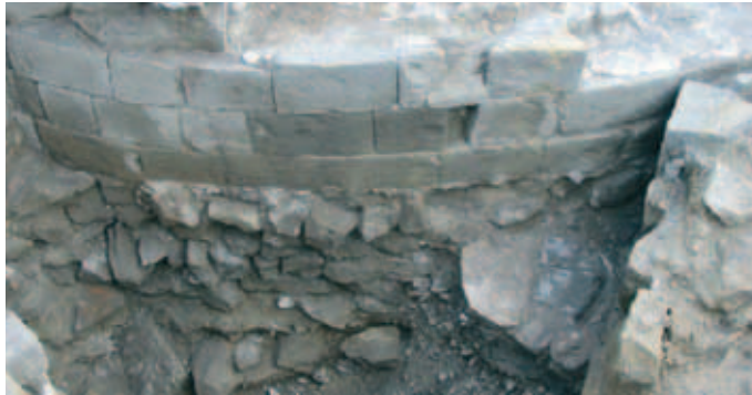
Abb. 40: Borgholzhausen. Blick auf die Außenfront des freigelegten Rundturms in der Ruine Ravensberg mit sehr sorgfältigem Quadermauerwerk und deutlich größerem Fundament. Foto: WMfA/S. Leenen.
