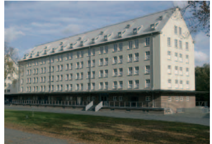
Abb. 2: Münster-Coerde. Blick auf das Zentralmagazin, in dem auch die Restaurierungswerkstätten, das Fotolabor und Bearbeitungsräume untergebracht sind. Foto: WMfA / S. Brentführer.
