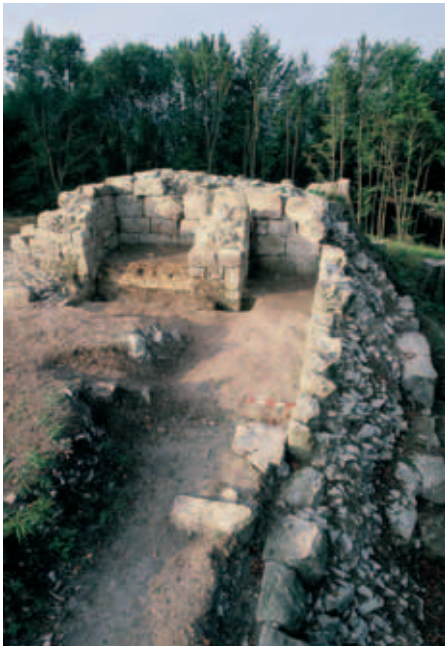
Abb. 26: Detmold-Berlebeck. Falkenburg. Blick auf die nordwestliche Ecke der Hauptburg mit freigelegter Ringmauer und Wachstube des Torhauses. Foto: WMfA / T. Pogarell.
