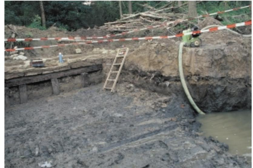
Abb. 20: Spenge, Werburg. Der Nordgiebel der Birkenpforte lag auf schweren, horizontal verlegten Eichenhölzern auf, die im morastigen Untergrund durch senkrechte Pfosten abgestützt waren. Der hohe Grundwasserspiegel erforderte ein dauerndes Abpumpen des eindringenden Wassers. Foto: WMfA/A. Madziala.
