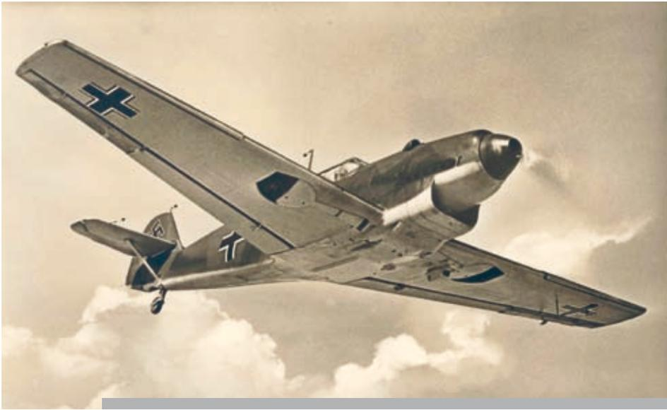
Abb. 14: Etwa 35 000-mal wurde die Messerschmitt Bf 109 in den Jahren 1937-45 gebaut. Sie war das wichtigste Jagdflugzeug der deutschen Luftwaffe und als Ganzmetallkonstruktion mit einziehbarem Fahrwerk mitbestimmend für den internationalen Trend des Flugzeugbaus. Der Zwölfzylindermotor der Messerschmitt BF 109 G 6 von Daimler-Benz leistete 1475 PS bei circa 36(l) Litern Hubraum. Der Motor hatte sich beim Aufschlag circa 4,50 m tief in den Boden gebohrt (re.).
