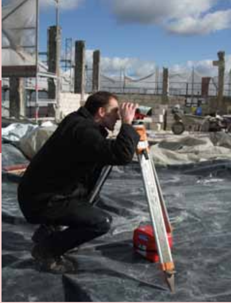
Bauleiter André Behrens am Nivelliergerät
