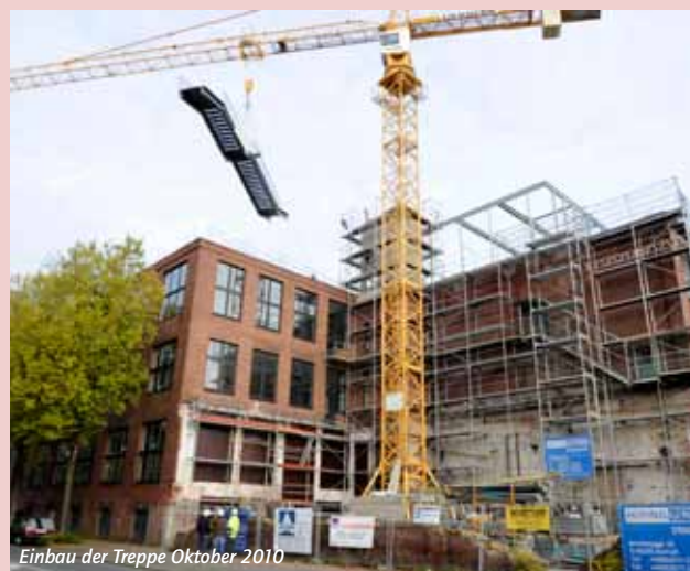
Einbau der Treppe Oktober 2010
