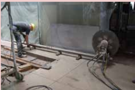
Heraussägen der Deckenelemente
