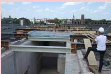
Auflegen der Träger für das neue Dachcafé
