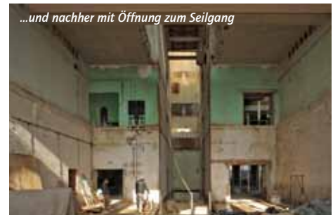
Maschinenhaus vor Entfernung der Decke...
