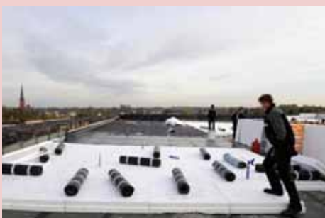
Energetische Sanierung des Daches
