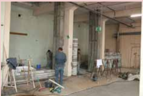
Schließen, Einziehen der neuen Seilgangwand
