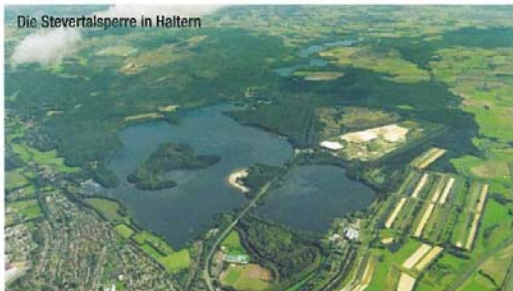
Die Stevertalsperre in Haltern
