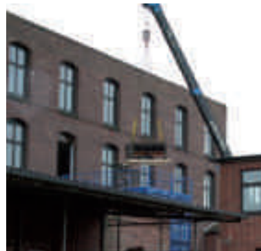
Einbringen von Maschinen in 1. Obergeschoss
