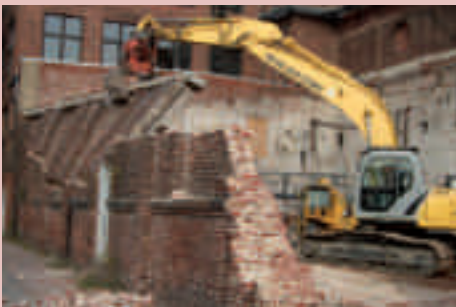
Abbruch der Kesselhauswand
