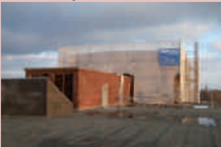
Standort des neuen Café auf dem Dach
