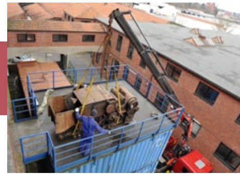
Maschinen zur Baumwollspinnerei werden in die Spinnerei gebracht, hier ein Teil des Öffnerzuges von 1910 aus Remiremont/F.
