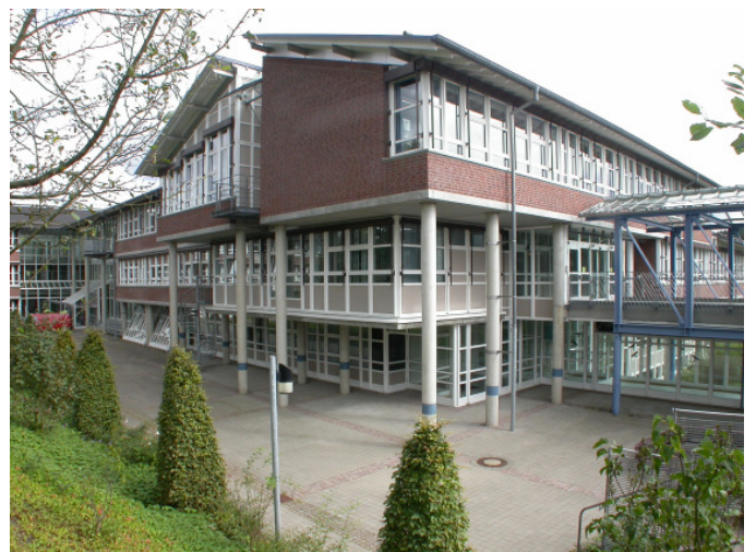
LWL. Förderschule, Förderschwerpunkt Sehen, Olpe
