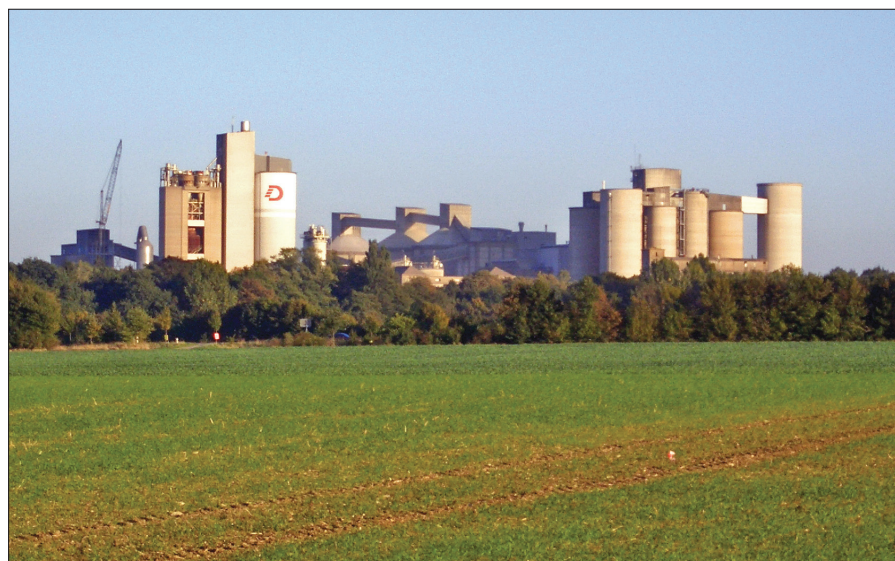
Abb. 1: Ehem. Dyckerhoff-Zementwerk Mark II Neubeckum (Foto: R. GROTHUES)
