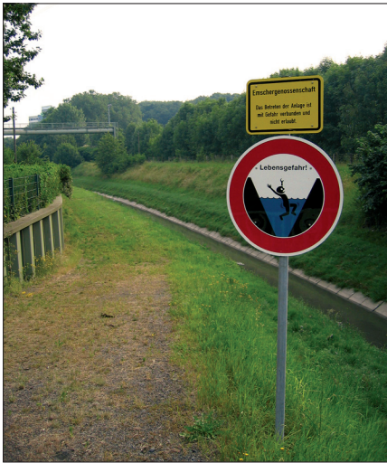
Abb. 1: Der technisch ausgebauten Schwarzbach in Gelsenkirchen (Foto: T. HELD, 21.06.2005)
