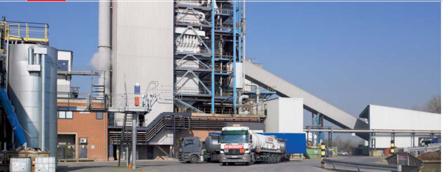
Das Kraftwerk im Lippewerk versorgt den Standort mit Strom, Dampf, Druckluft und Wärme – gewonnenen aus alternativen Energieträgern.
