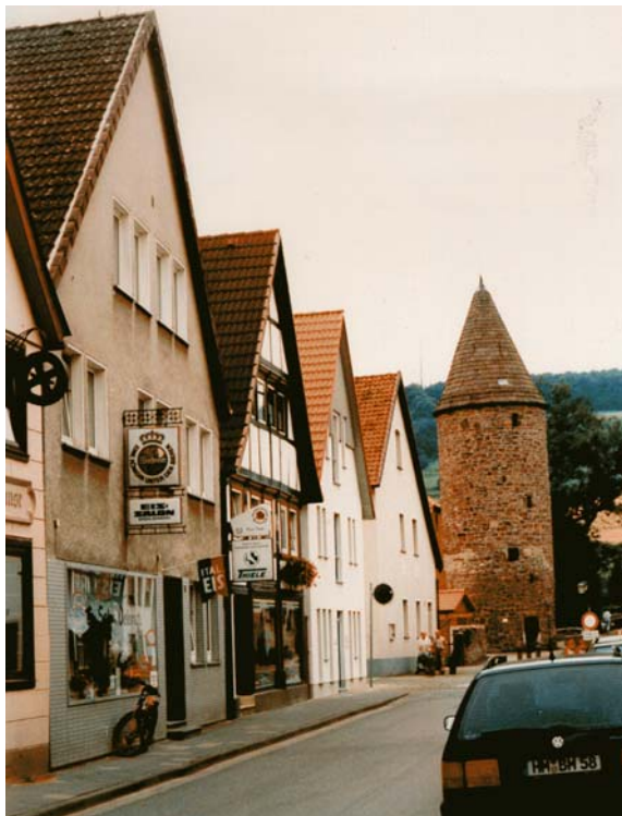
Abbruch und Neubau Brückenstraße 7
