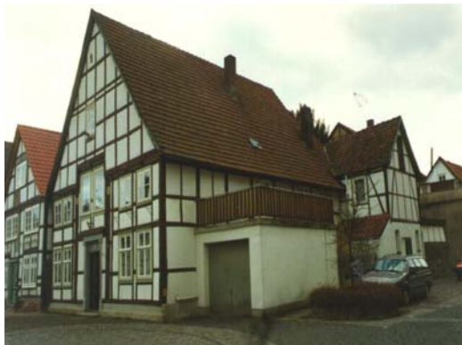
Gebäude vor dem Umbau 1993
