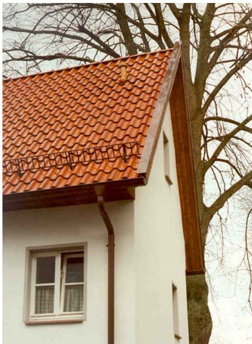
Ortgang mit Windfeder, farbig abgesetzte Fensterfaschen
