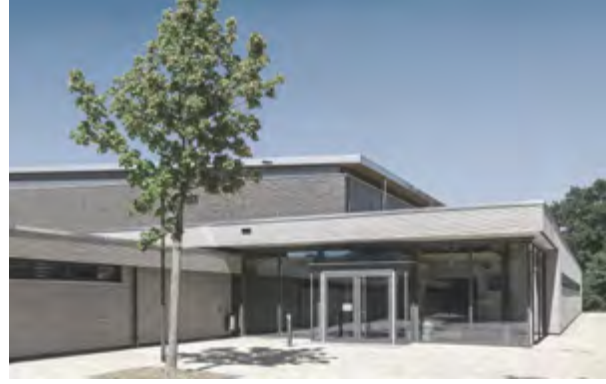
66// Neubau einer Sporthalle, Senden-Ottmarsbocholt
