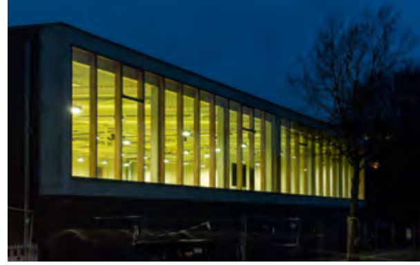
54// Neubau Sporthalle Ost, Münster
