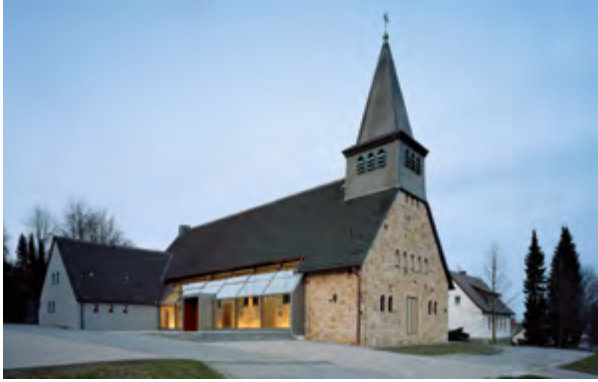
37// Umbau der Heilig Kreuz Kirche zu einem kirchlichen Zentrum mit integriertem Gemeindehaus, Horn
