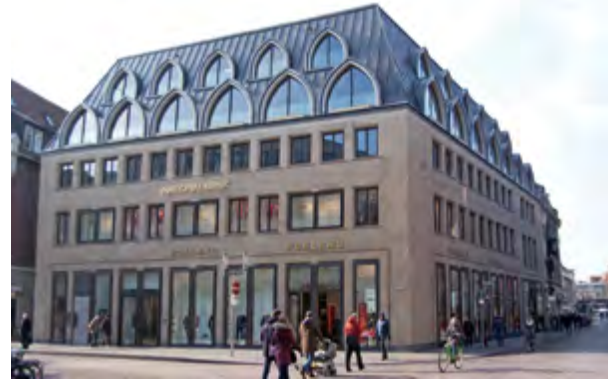
50// Umbau Büro- und Geschäftshaus der ehemaligen Dresdner Bank, Münster
