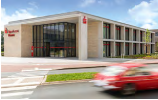
33// Neubau einer Sparkassenfiliale, Hamm-Werries
