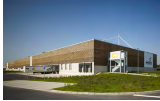
14// Neubau einer Fertigungshalle am Hettich Produktionsstandort „In der Lohge“, Bünde
