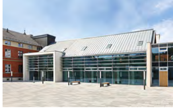
62// Umnutzung und Sanierung des Gebäudeensembles Stadelhof zur Geschäftsstelle der VHS, Paderborn
