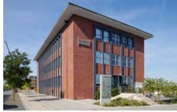
18// Sanierung eines ehemaligen Labors zum Bürogebäude Labor Phoenix, Dortmund
