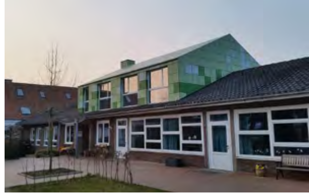
58// Umbau und Erweiterung des Familienzentrums, Münster-Handorf
