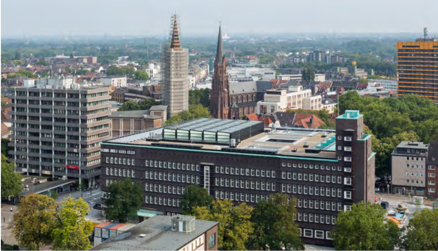
Auf dem Dach befindet sich eine 270 m 2 große Photovoltaikanlage
