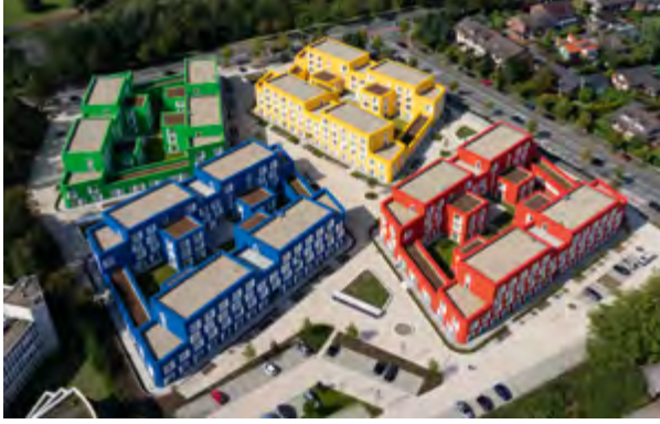
41// Neubau Böselburg Studentenwohnen, Münster
