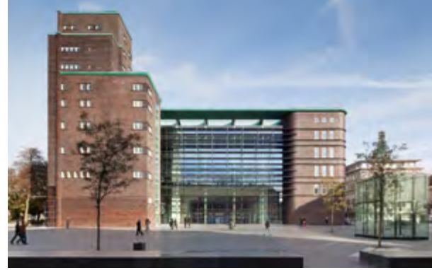
30// Umbau des Hans-Sachs-Hauses, Gelsenkirchen
