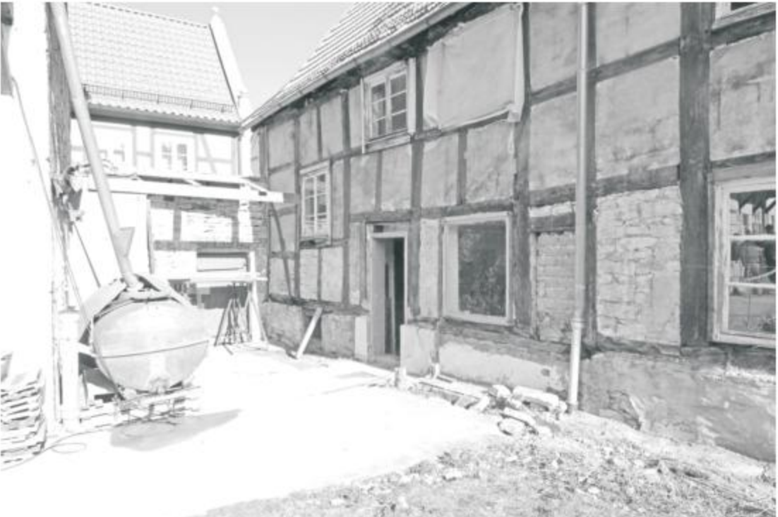
Zustand Fachwerkdoppelhaus vor Sanierung
