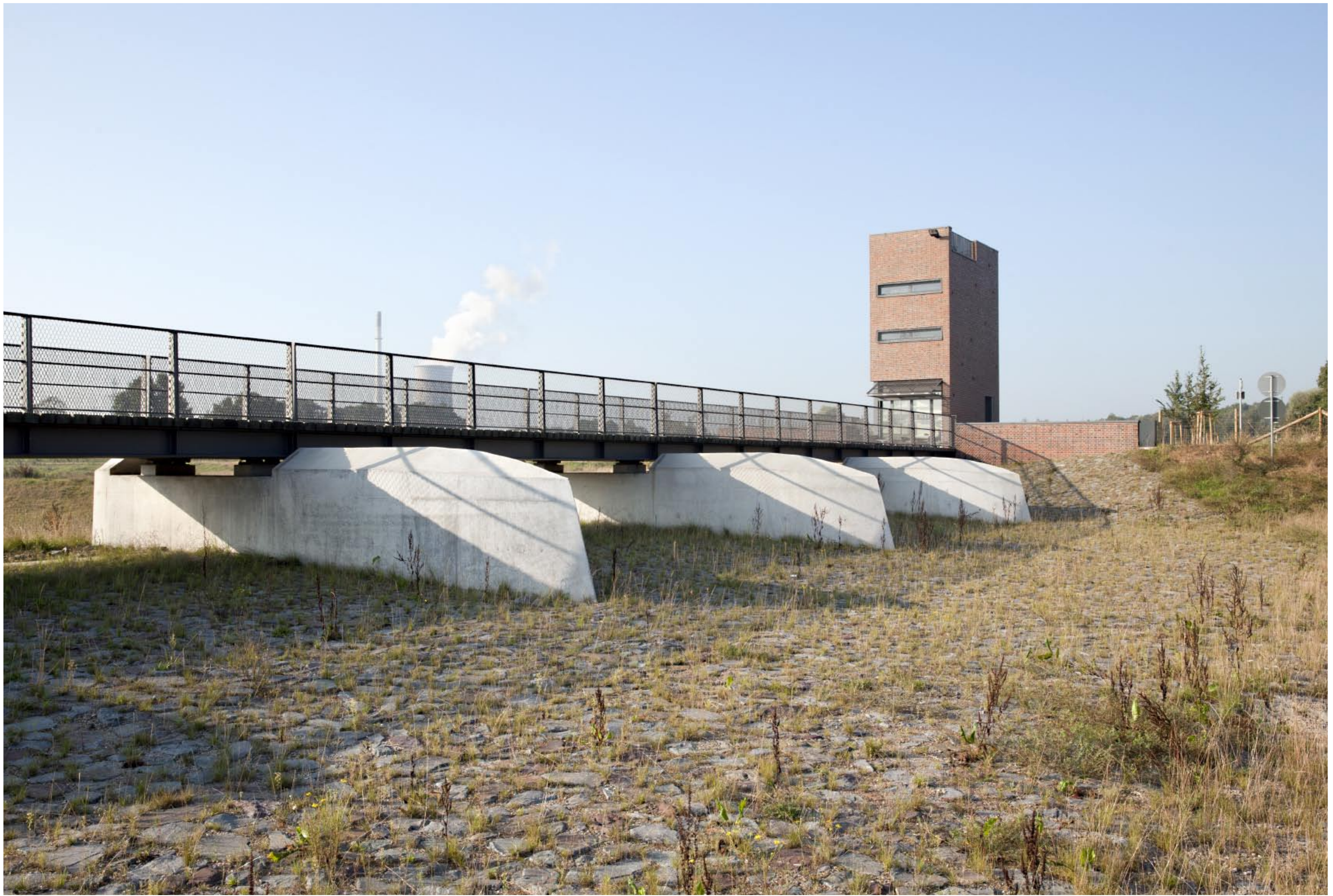
Auslassbauwerk und Betriebsgebäude
