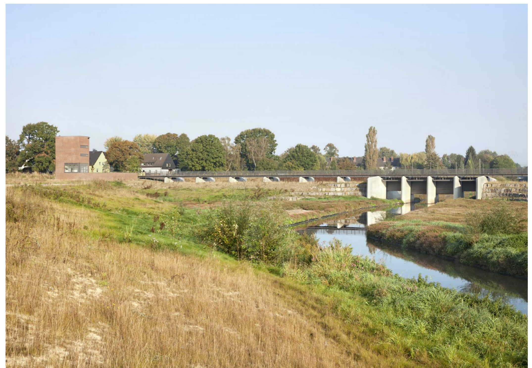
Blick über das Rückhaltebecken
