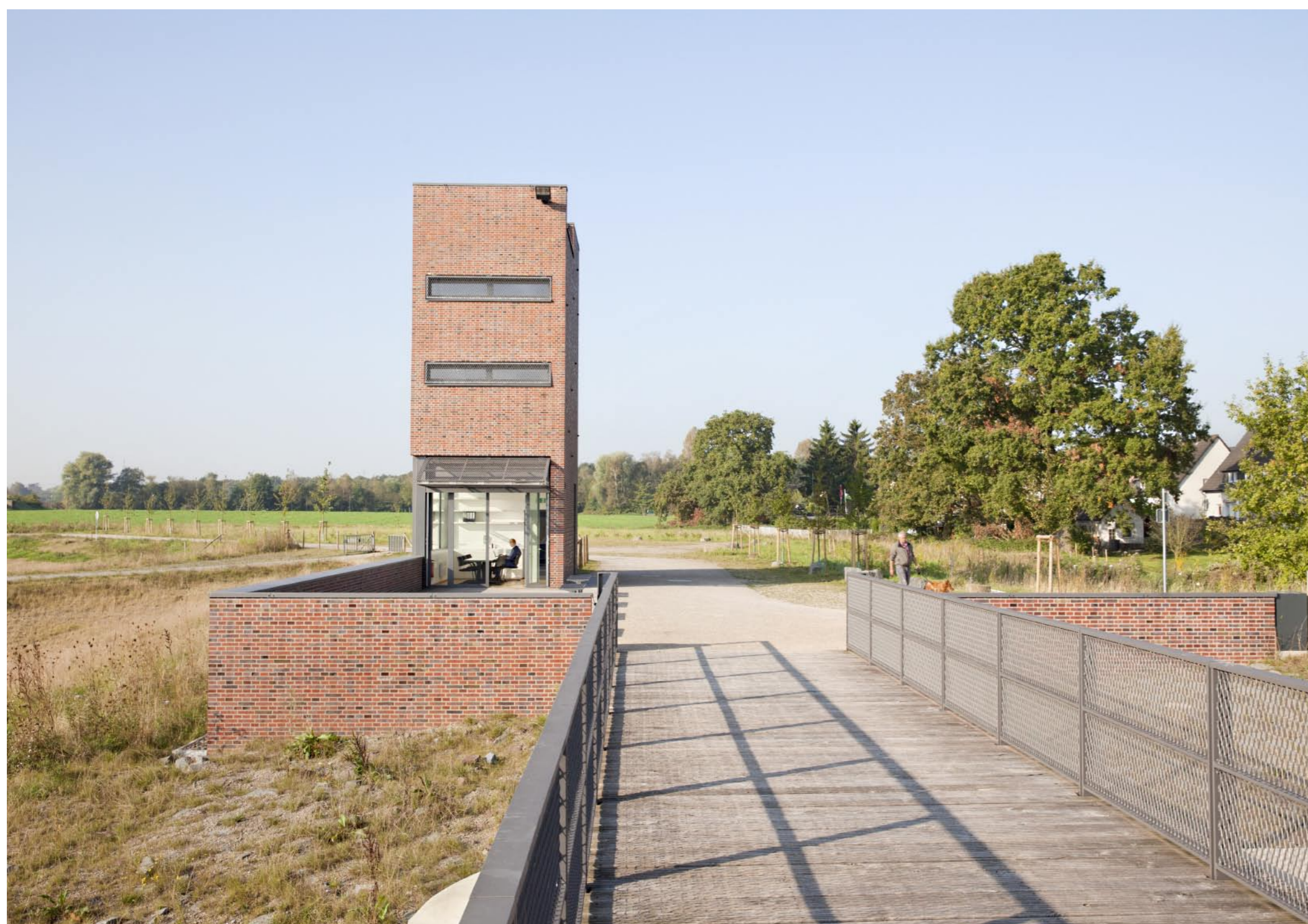
Betriebsgebäude - Blick vom Steg
