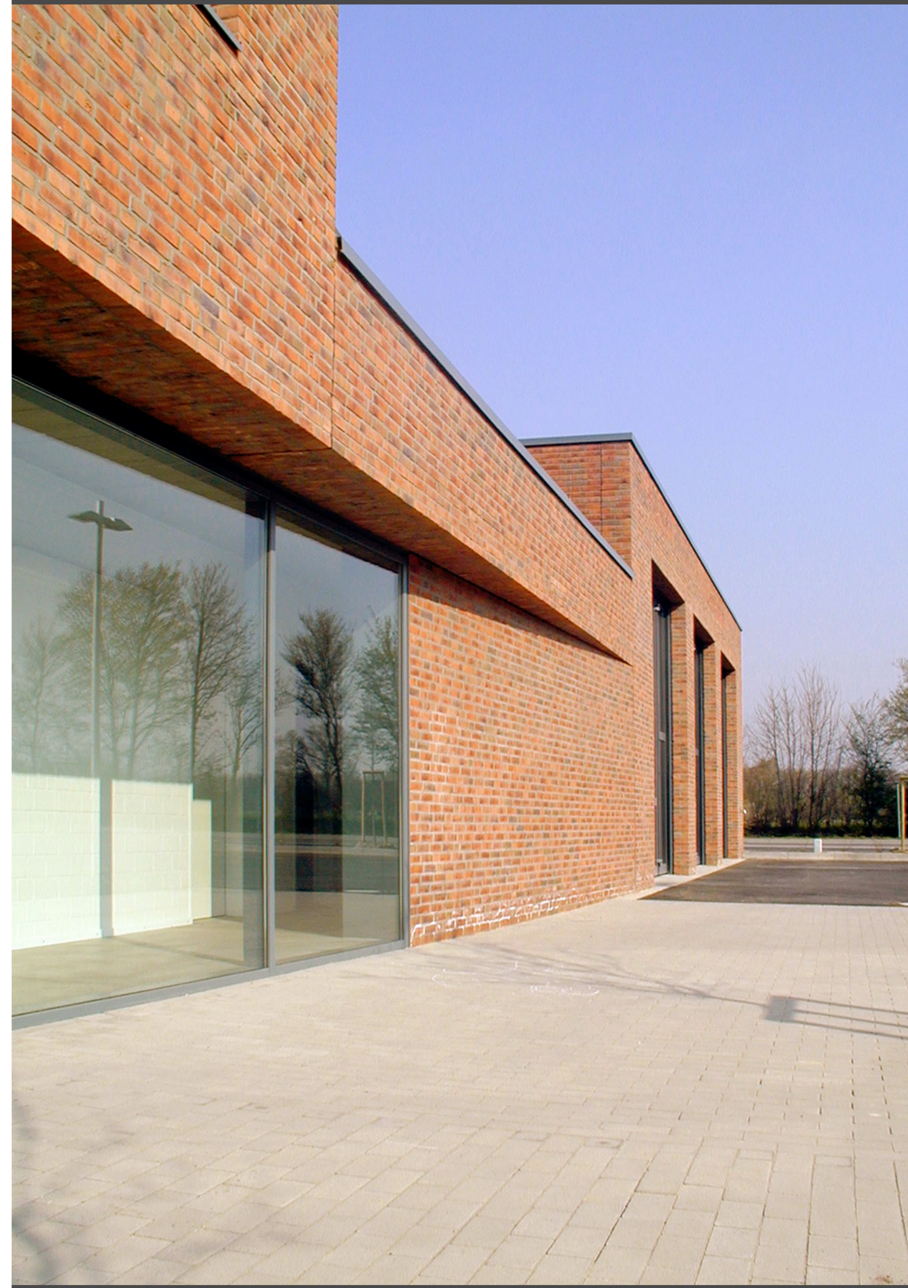
Ansicht Ost, Haupteingang
