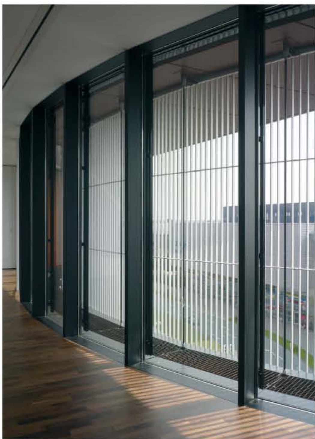
Innenansicht der Medienfassade
