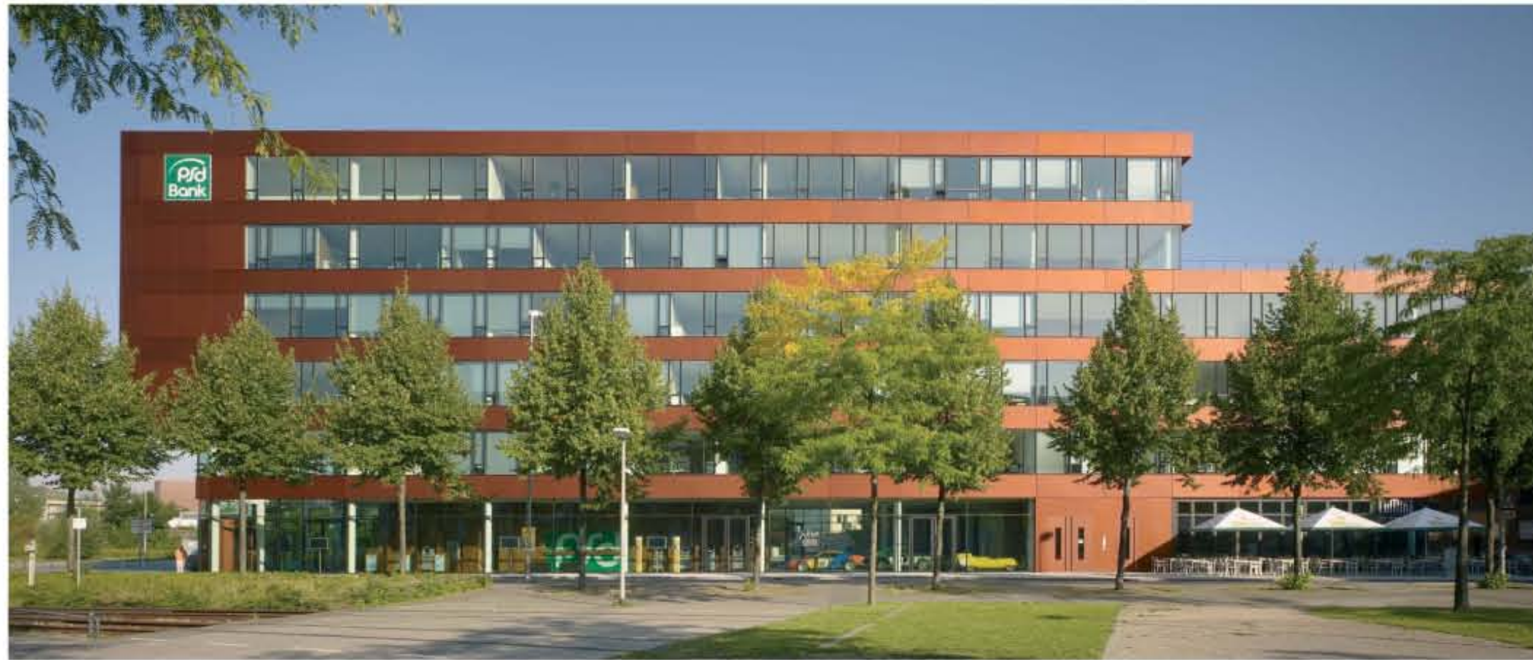
Ansicht vom Hafenplatz
