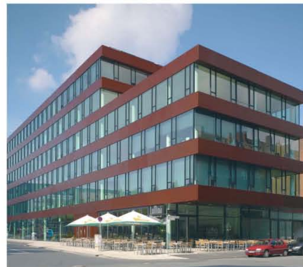
Ansicht vom Mittelhafen
