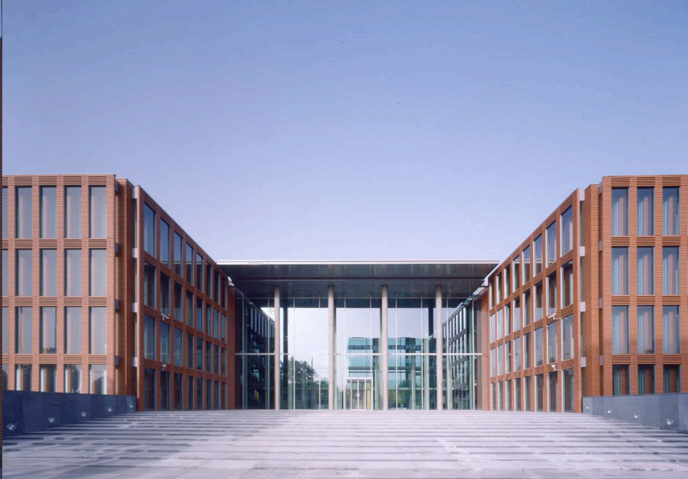
Haupteingang Weseler Straße
