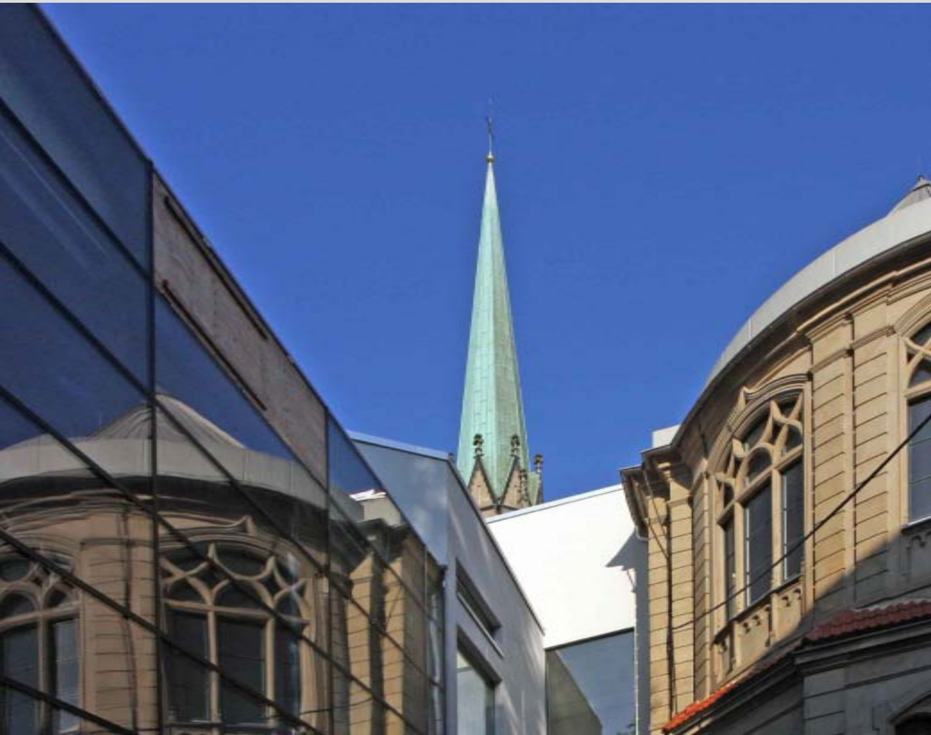
Fassaden Altbau / Neubau
