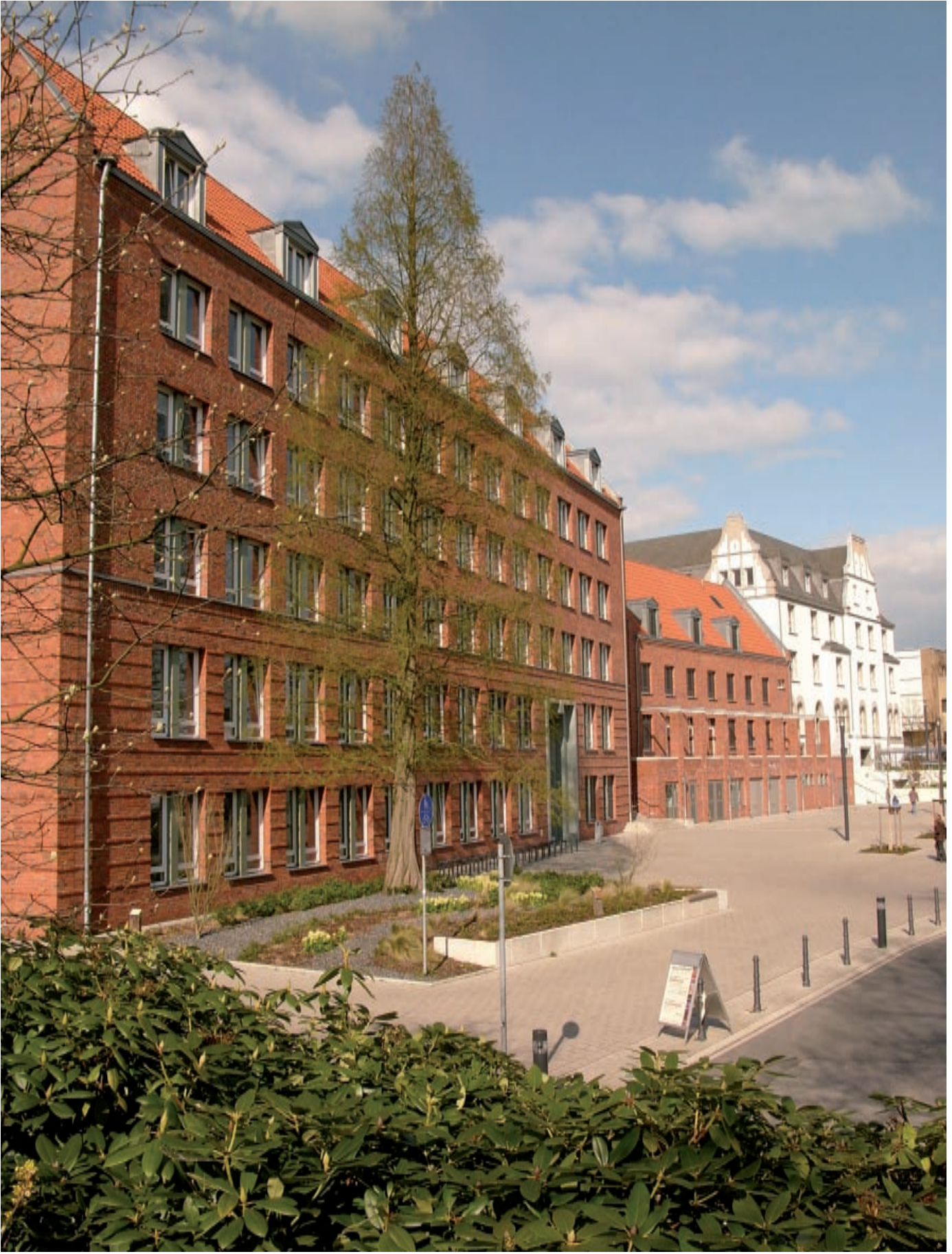
Südfassade – Parkplatzebene und Verbindungsbau zum alten Rathaus mit Cafeteria
