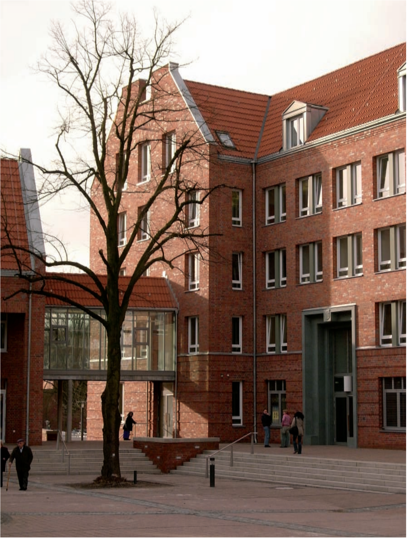
Haupteingang und Passage zum Parkplatz
