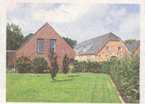
Neu und alt nebeneinander: Die Siedlung Schulze Mesum, Rheine
