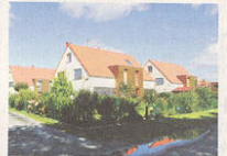
Siedlung in Gütersloh, Architekten Schröder & Gaisendrees, Gütersloh
