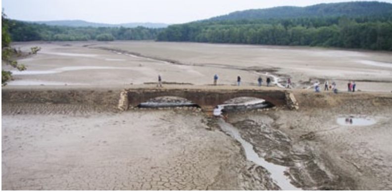
Möhne-Talsperre während Wartungsarbeiten // Foto: LWL / M. Philipps
