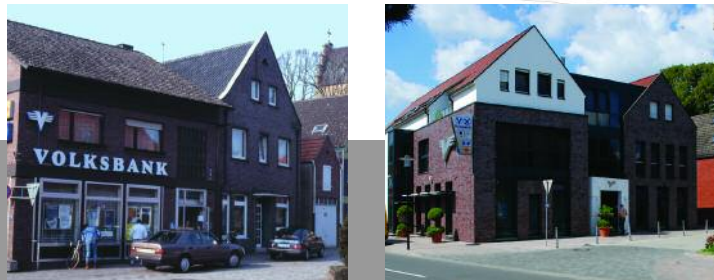
Neubau Volksbank in Metelen: Bestand (li.) und Neubau nach erfolgtem Testentwurf (re. und Titelseite); Architekt: Gerhard Georgi, Münster
